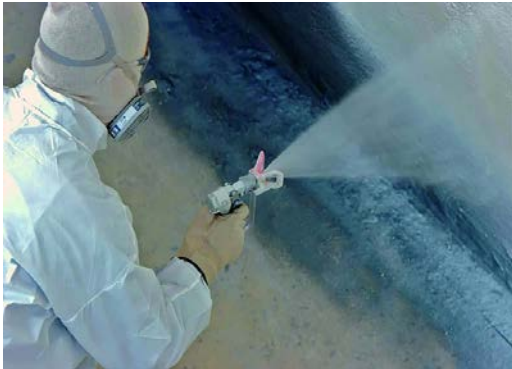
Краска-протектор электромагнитного излучения. Применяется для защиты от электромагнитного излучения (Германия)
