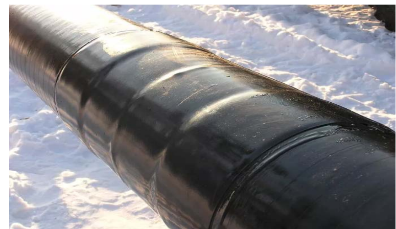
изоляция переходов «земля-воздух»
